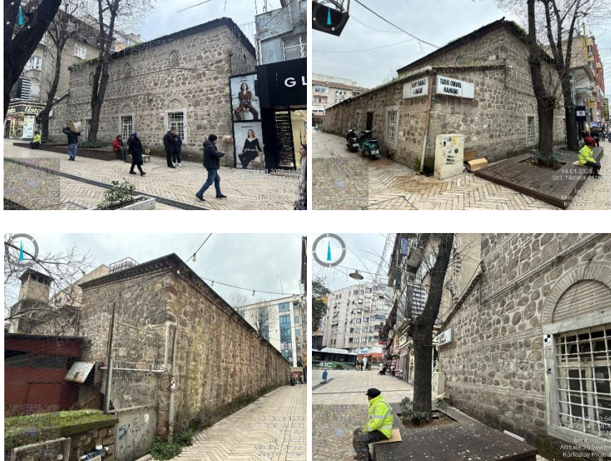
Şekil 6.51 (17) Ömerağa Hamamı (Kethüda Mehmet Bey Hamamı)- Proje Güzergâhı İçinde Anıtsal Eser (Önerilen tünel üst kotunun yaklaşık 33 metre üzerinde yer alan kültürel varlık)
