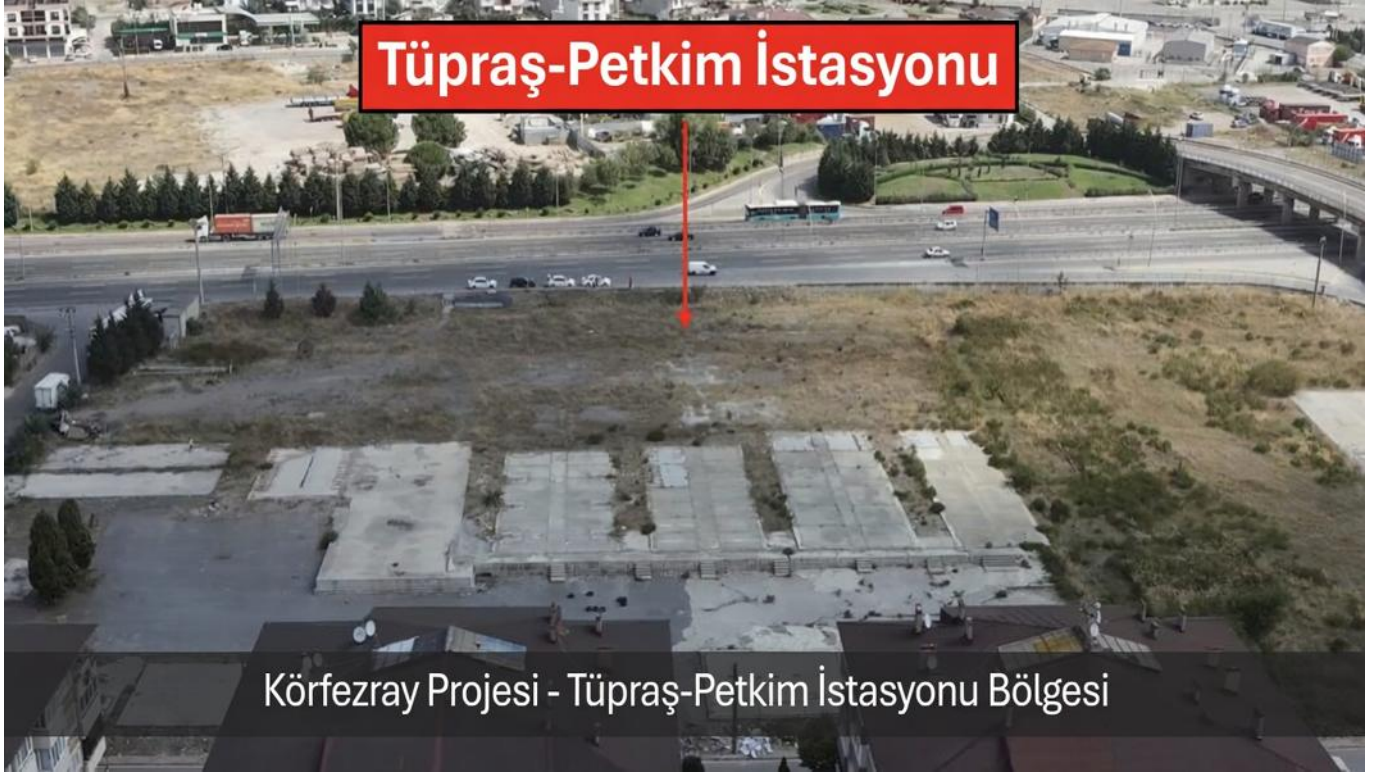
Şekil 6.10 Tüpraş-Petkim İstasyonu Görünümü (Bakış Noktası 1)
