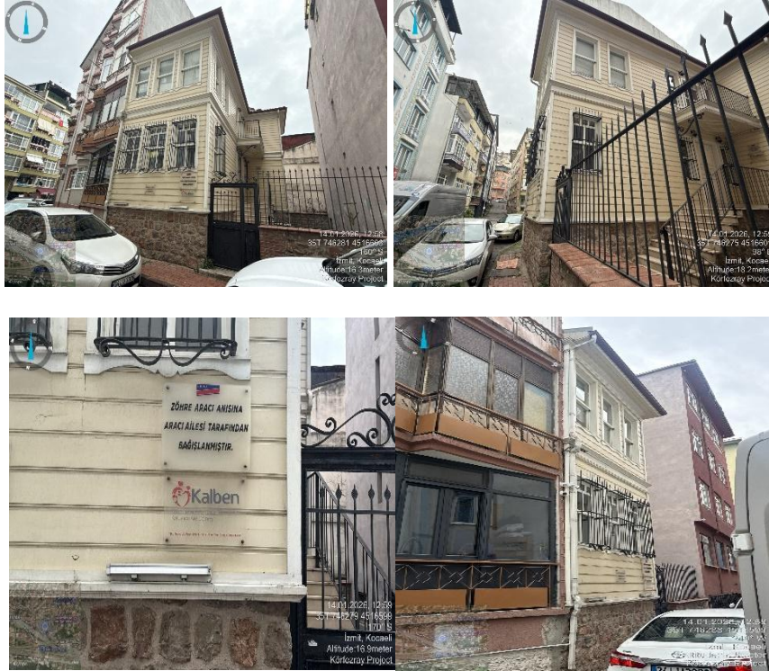
Şekil 6.43 (9) Zöhre Aracı Köşkü- Proje Güzergâhı İçinde Anıtsal Eser (Önerilen tünel üst kotunun yaklaşık 31 metre üzerinde yer alan kültürel varlık)
