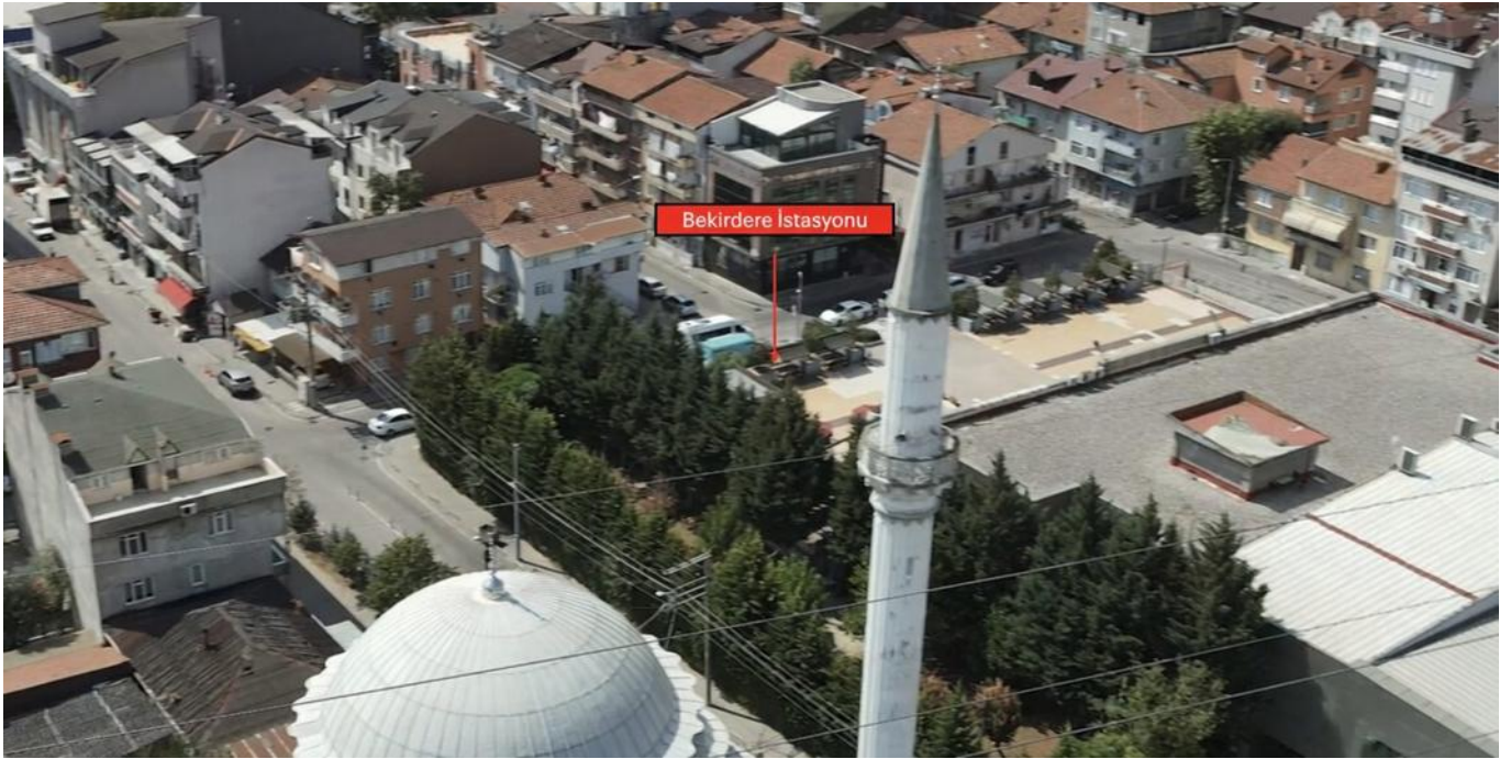
Şekil 6.21 Bekirdere İstasyonu Görünümü (Temsili Bakış Noktası 12)
