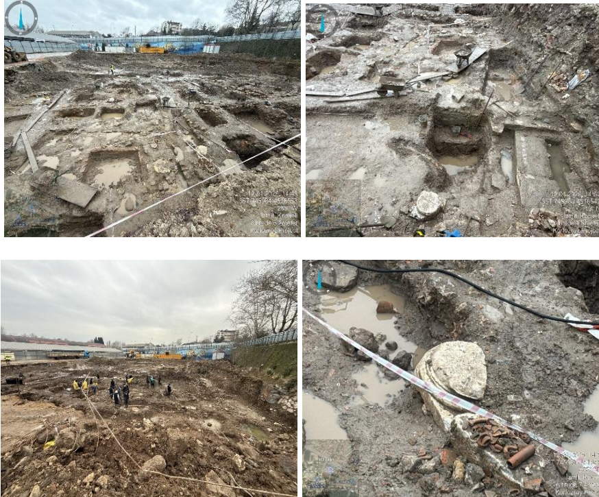
Şekil 6.39 (5) Sekapark Anıtsal Eser (Roma Yerleşim Alanı), Proje kapsamında “Sekapark İstasyonu”
