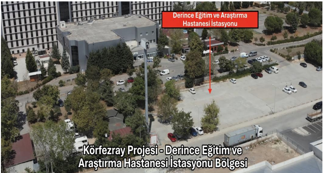
Şekil 6.13 Derince Eğitim ve Araştırma Hastanesi İstasyonu Görünümü (Bakış Noktası 4)
