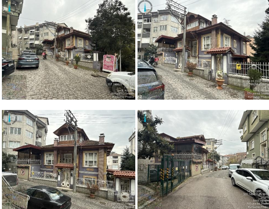
Şekil 6.46 (12) Şekerci Cahit Konağı – Anıtsal Eser, Proje Güzergâhı İçerisinde (Kültürel miras varlığı, önerilen tünel taç kotunun yaklaşık 59 metre üzerinde düşey ayırım mesafesinde yer almaktadır.)
