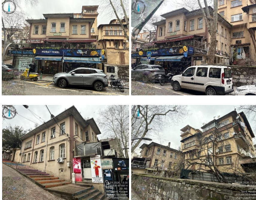
Şekil 6.49 (15) Arzen Sanat Evi- Proje Güzergâhı İçinde Anıtsal Eser (Önerilen tünel üst kotunun yaklaşık 42 metre üzerinde yer alan kültürel varlık)
