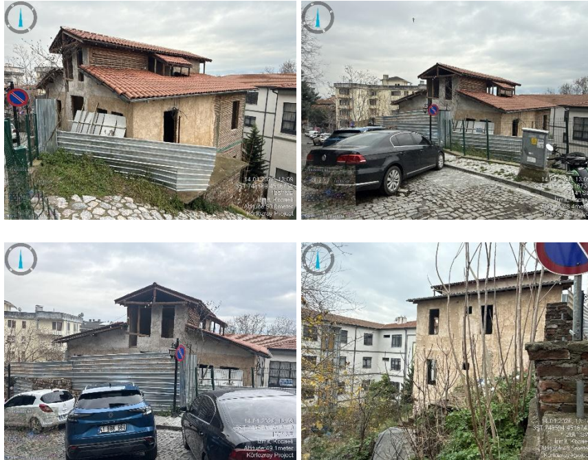
Şekil 6.45 (11) Konak 190_20 – Anıtsal Eser, Proje Güzergâhı İçerisinde (Kültürel miras varlığı, önerilen tünel taç kotunun yaklaşık 63 metre üzerinde düşey ayırım mesafesinde yer almaktadır.)
