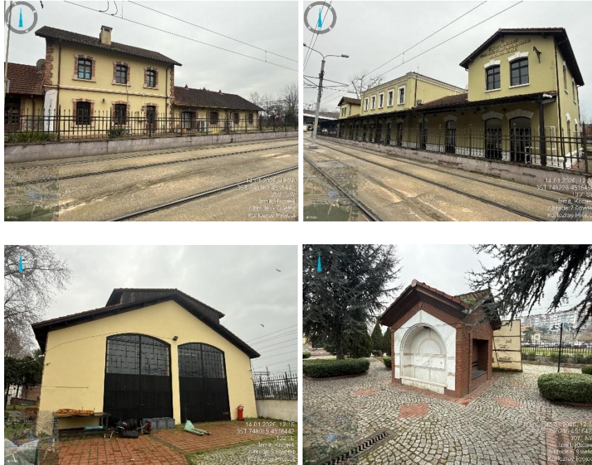
Şekil 6.40 (6) İzmit Tren İstasyon Binaları (7 Bina)- Proje kapsamında “Sekapark İstasyonu” Anıtsal Eser
