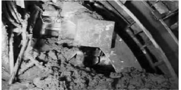
Şekil 7.6 Karstik Mağarada Gevşek Dolgu Malzemesi Çökmesi ve TBM Jammingi (Zarei ve ark., 2012)
